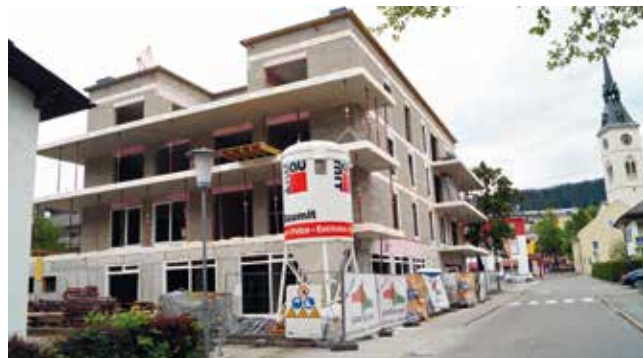
Das Wohn- und Geschäftsgebäude in der Bauphase
