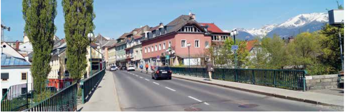
Die Sanierung der Lieserbrücke durch das Land Kärnten hat den größten Einfluss auf den Straßenverkehr
